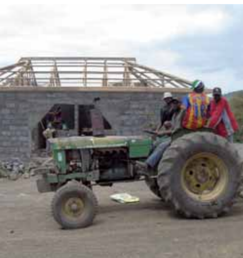
Die neue Krankenstation im Rohbau
