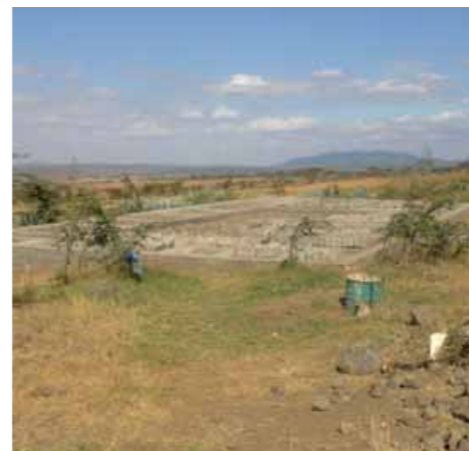
Mit den Bauarbeiten an der KHS wurde im Herbst 2005 begonnen
