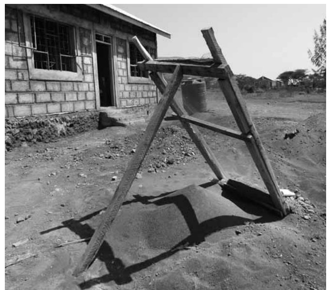
Einfach aber effizient: Sieb für den Sand.
