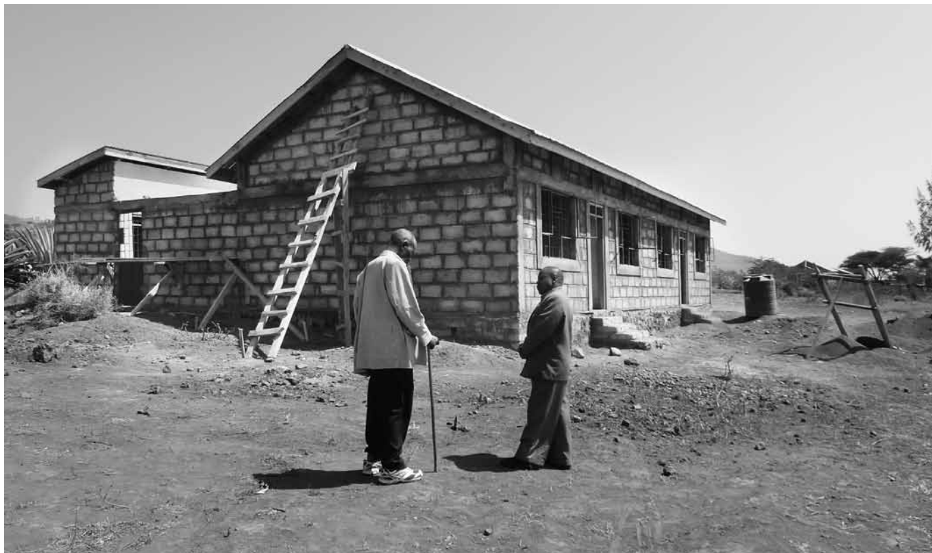
Kurz vor Fertigstellung: eines der neuen Doppel-Lehrerhäuser an der KPS
