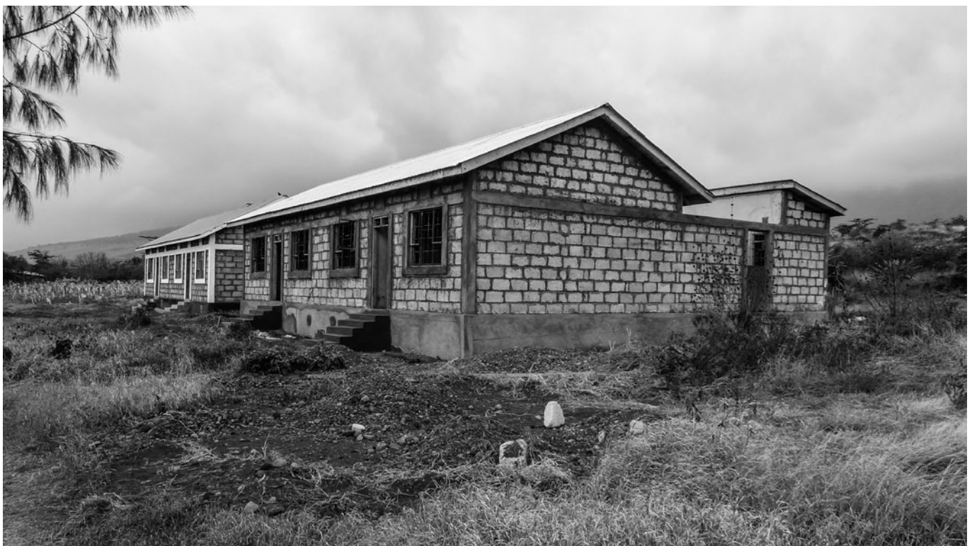
Kurz vor der Fertigstellung: Ein weiteres Doppellehrerhaus an der KPS
