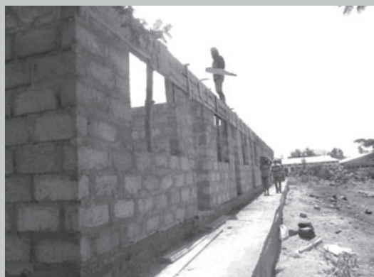
Ebenfalls fortgeschritten ist der Bau eines Hauses für sechs Lehrkräfte an der KSS
