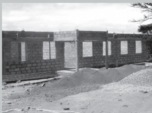
Im Bau befindet sich die Knabenunterkunft an der KPS
