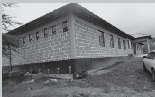
Inzwischen abgeschlossen ist der Bau der Knabenunterkunft an der Momella Secondary School
