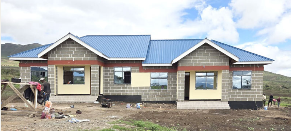
Bild: Das fertig gebaute Doppelhaus für Aufsichtspersonen
