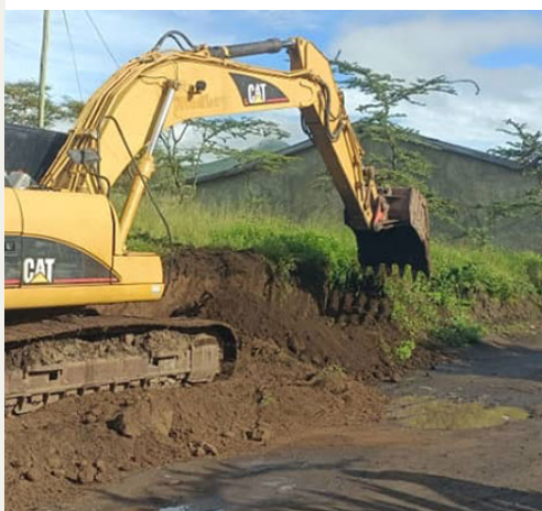
Bild: Der Entwässerungsgraben wird gebaut
