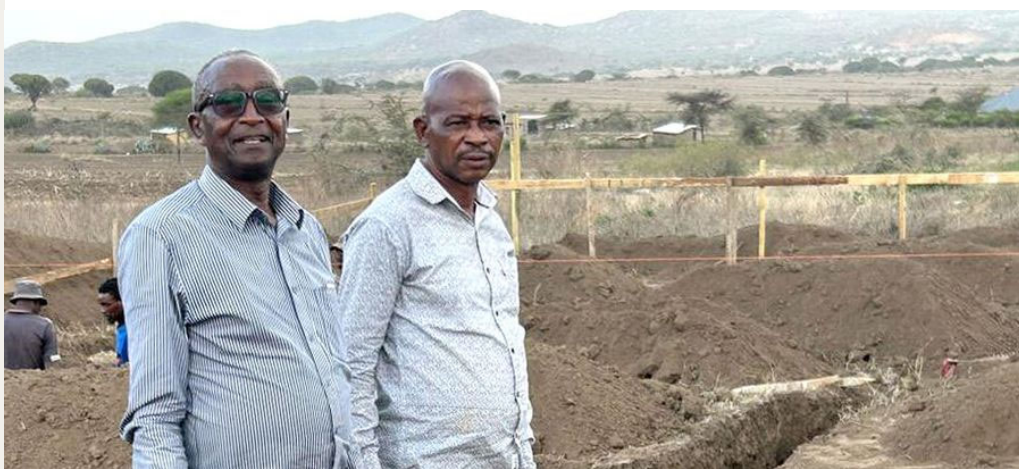
Bild: Jubilant Wera (links) und Hamidu Juma Ramadhani (rechts) bei der Inspektion der Bauarbeiten
